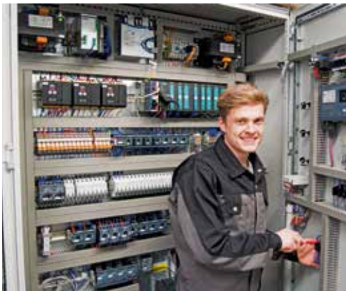
In der Elektro-Abteilung werden komplexe Schaltanlagen montiert und verdrahtet
